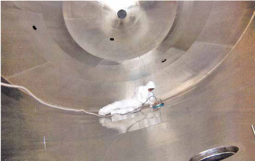
Abbildung 3: Prüfung einer Schweißnaht am Übergang vom Hauptbehälter zu einem Stutzen.
