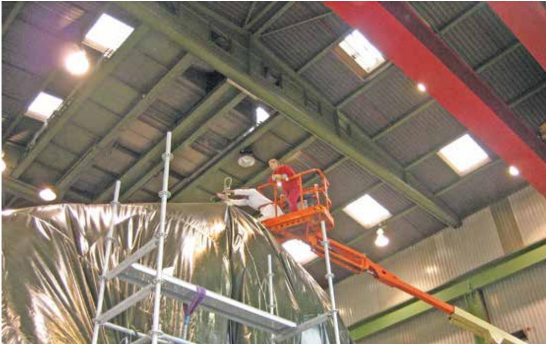
Abbildung 4: Die Arbeiten am Hauptspektrometertank erforderten höchsten Einsatz von den KATRIN-Mitarbeitern
